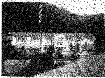
正面より見た深小校舎
